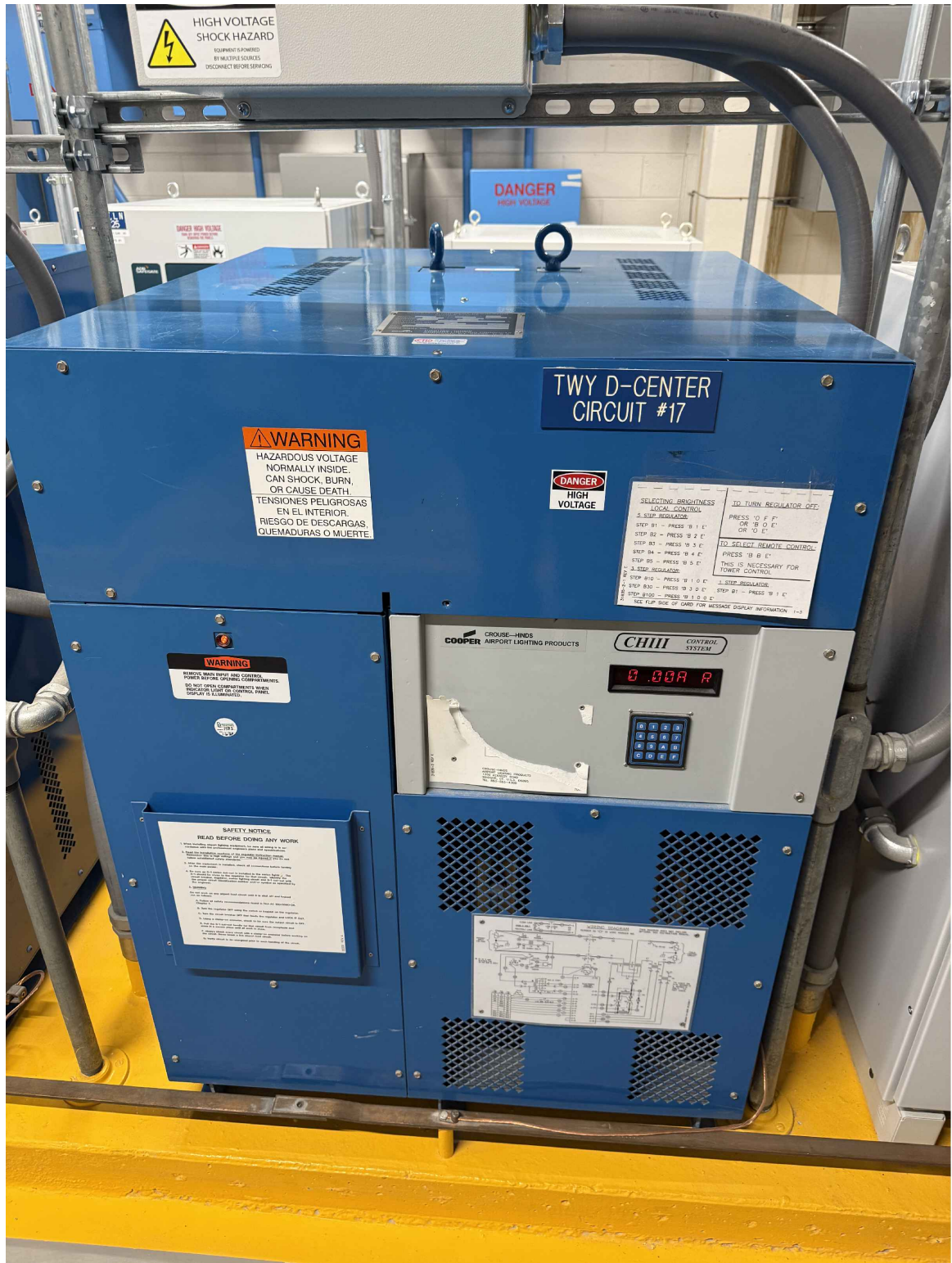
4 E302 EXISTING TWY D-CENTER REGULATOR SCALE: N.T.S
