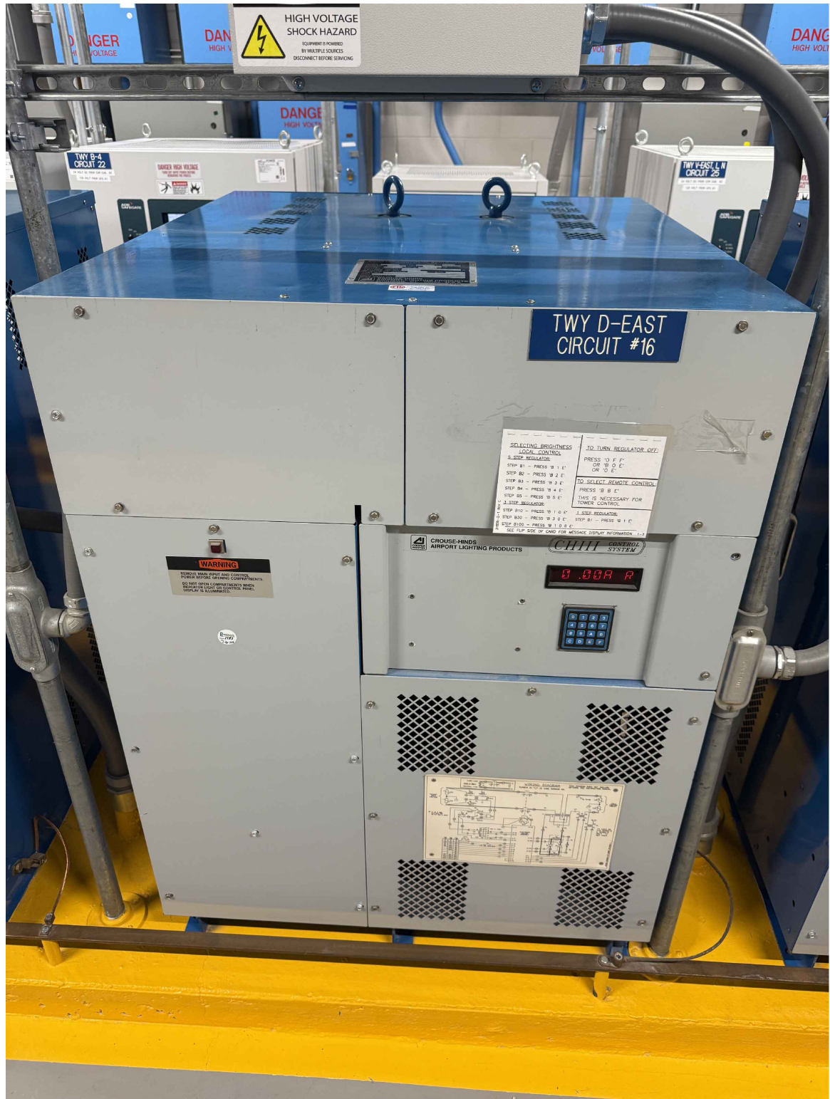
3 E302 EXISTING TWY D-EAST REGULATOR SCALE: N.T.S
